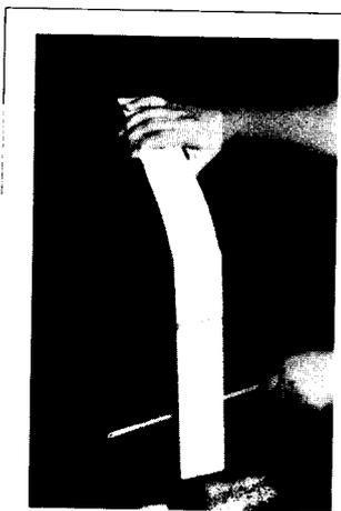
**6** Use una segueta para hacer un surco en la sección nueva para los prensadores de la tapa (si es necesario). Instale la banda de la tapa.
